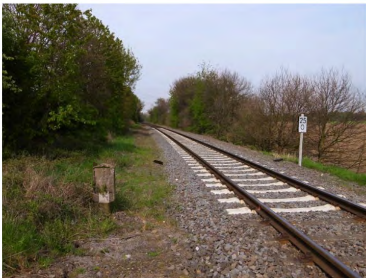
Abb. 8: Wenige Meter weiter südlich endet das Gleis aus Richtung Duisburg, das einst als Hauptbahn errichtet wurde und heute als Anschlussgleis genutzt wird.
