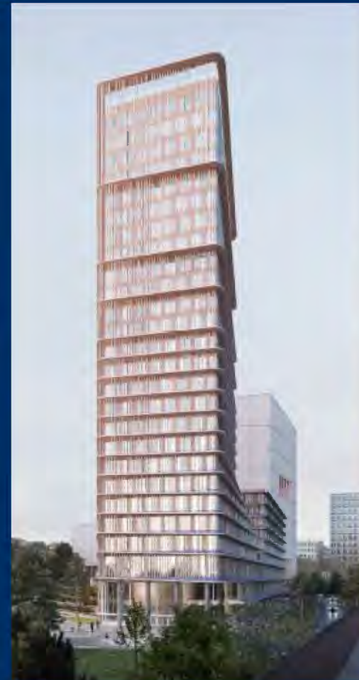
Ansicht von Rheinkniebrücke, Blickrichtung Osten
