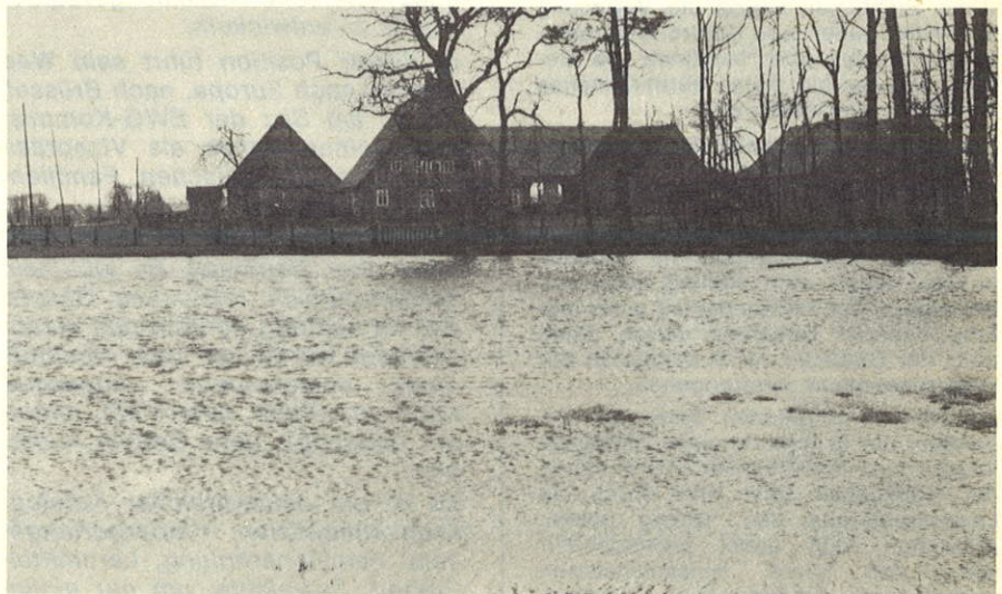
Aus dem vorgeschlagenen Hilfsfonds könnte künftigt auch Opfern von Hochwasserkatastrophen — wie damals in der Großen Aue im Kreis Lübbecke — geholfen werden. Foto: Horstmann
