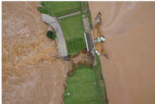
Abbildung 3: Hochwasserrückhaltebecken Horchheim am 15.07.2021 (Foto: Erftverband).
