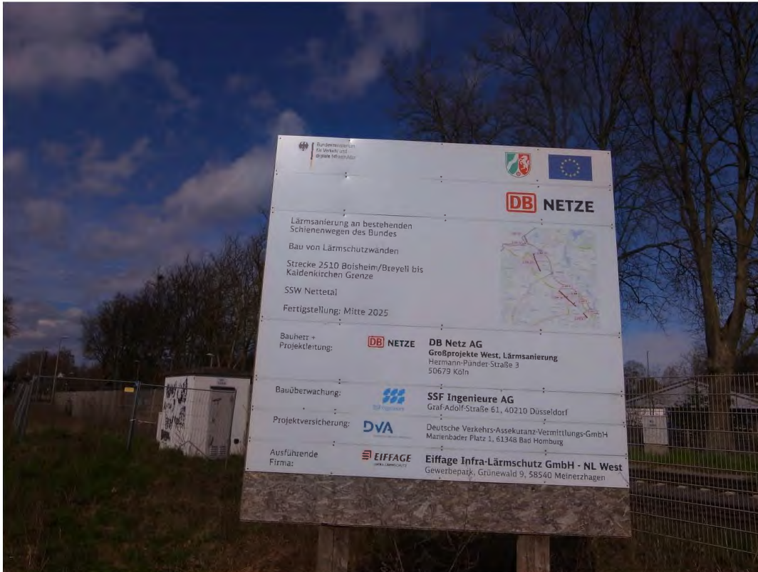
Abb. 4: Baustelleninformation zum Lärmschutz in Breyell. Die Förderung durch die EU und durch das Land NRW ist ausgewiesen.
