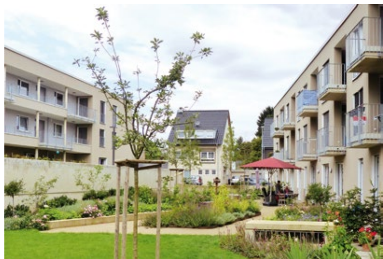
Mit Loggien, Balkonen und halboffenen Laubengängen öffnen sich die Wohngebäude zum Quartier und zu den Grünanlagen.
