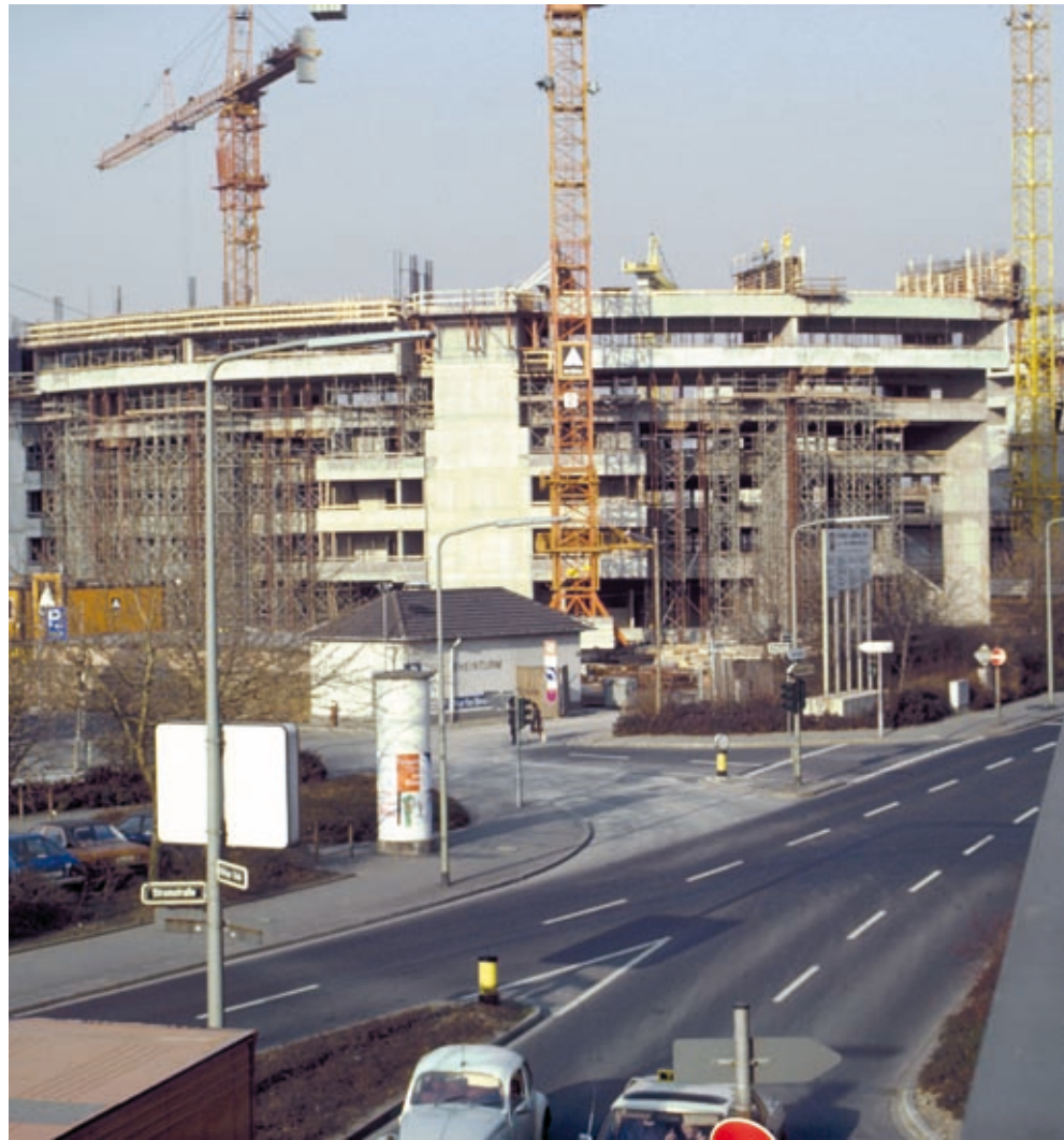
Rohbau von der Hochstraße aus gesehen, 1983
