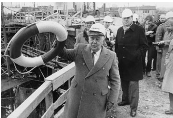
Landtagspräsident van Nes Ziegler bei der Besichtigung der Baustelle vor dem „gefluteten“ Plenarsaal, Februar 1983
