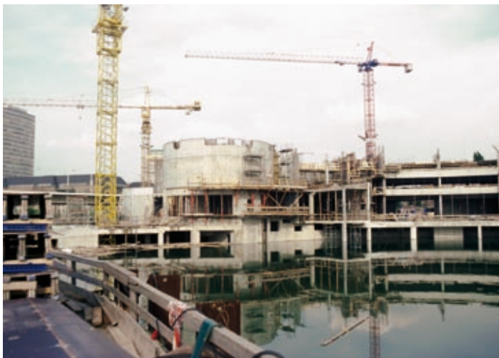
Rohbau während des Winterhochwassers 1983: Die Baugrube wird mit Absicht mittels eines Tiefbrunnens in Höhe des Rheinhochwassers geflutet. Bei fallendem Pegelstand wurde das Wasser wieder in den Rhein abgepumpt. Die Presse berichtet: „Landtag säuft ab“.
