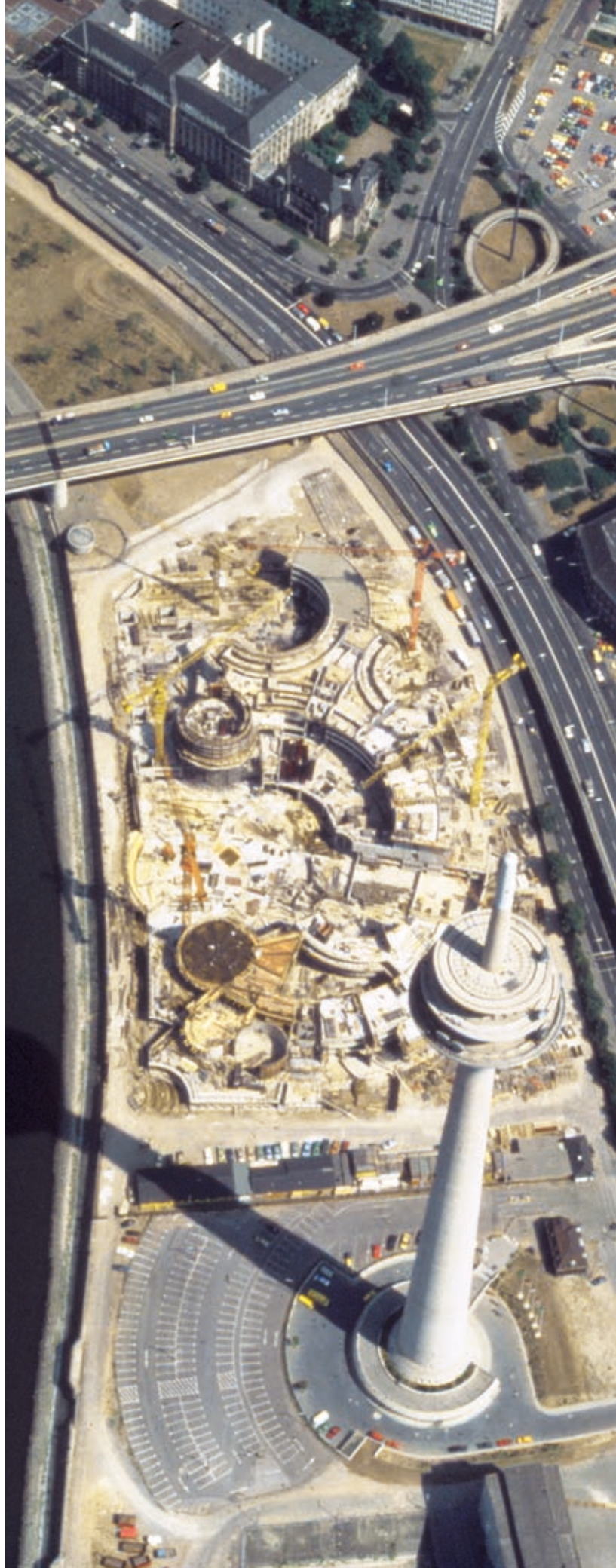
Gesamtbaustelle, Luftaufnahme mit Fernmeldeturm, 1983
