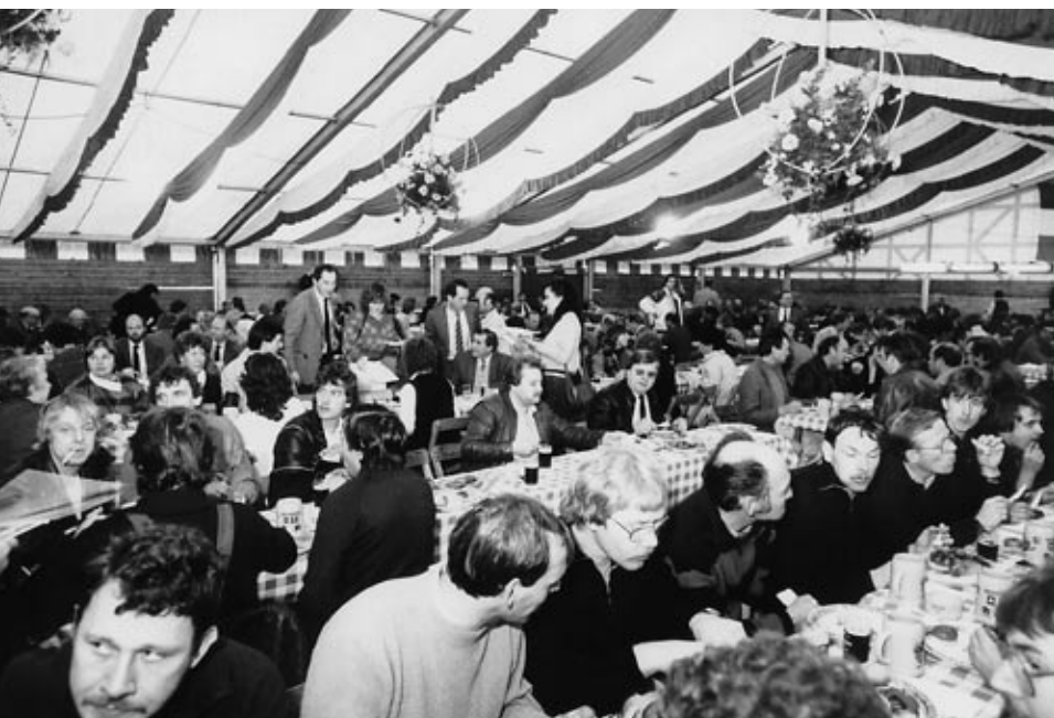
Richtfest für den Landtagsneubau
