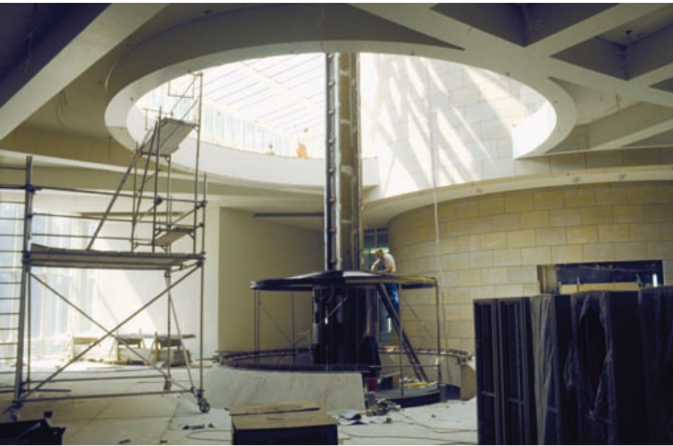
Montage des Besucheraufzugs in der Bürgerhalle, 1987
