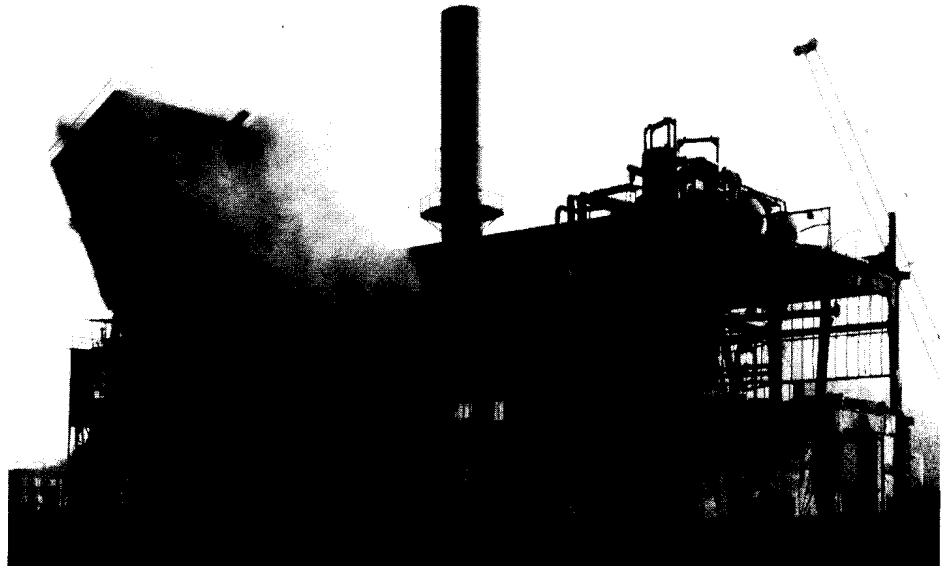
Im Frühjahr 1993 wurden auf dem ehemaligen Thyssengelände die letzten Bauten gesprengt. Nach Prüfung der Umweltverträglichkeit und des Bodens konnten im September 1994 die Bauarbeiten für das „Centro“ beginnen, die nach der Rekordzeit von zwei Jahren beendet sein werden.
