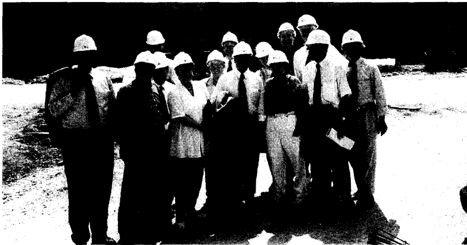
Gut behütet und tief beeindruckt besichtigten die Mitglieder des Sportausschusses den Rohbau der Rad- und Schwimmhallen, die in Berlin als Vorgriff auf die Bewerbung der Stadt für Olympia 2000 derzeit im Entstehen begriffen sind. Auf dem Bild zweiter von rechts der stellvertretende Ausschlußvorsitzende Heinz-Helmich van Schewick.
