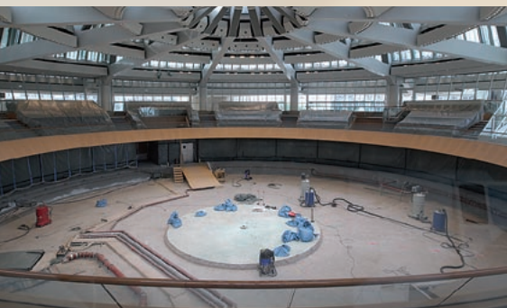
Woche 1: Der Plenarsaal ist entkernt, besteht nur noch aus nacktem Beton.
