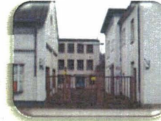
Nordwalde Wattendorff: Verkauf an Investor erfolgt; B-Plan in Aufstellung; Abriss in Vorbereitung
