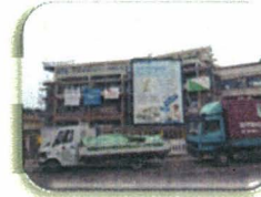
Troisdorf Rücker: Baubeginn für Wohnungsbau erfolgt
