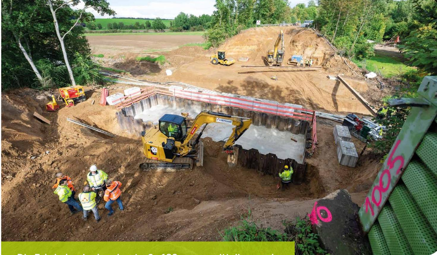
Die Fahrbahn der Landesstraße 182 war unmittelbar nach dem Unwetter im Bereich der Swistbachbrücke eingebrochen. Einige Tage später stürzte auch die Brücke ein, nachdem eines der Brückenwiderlager durch den angestiegenen Swistbach unterspült wurde und nachgab.
