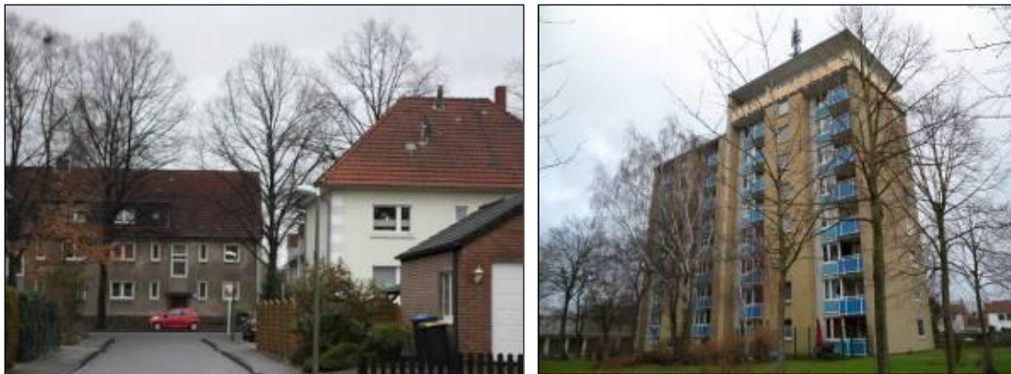
Abb. 4: Vernachlässigte Bestände der LEG gegenüber den sanierten Beständen von Evonik (In den Kämpfen), Punkthochhaus in der Schwabenstraße (Deutsche Annington)
